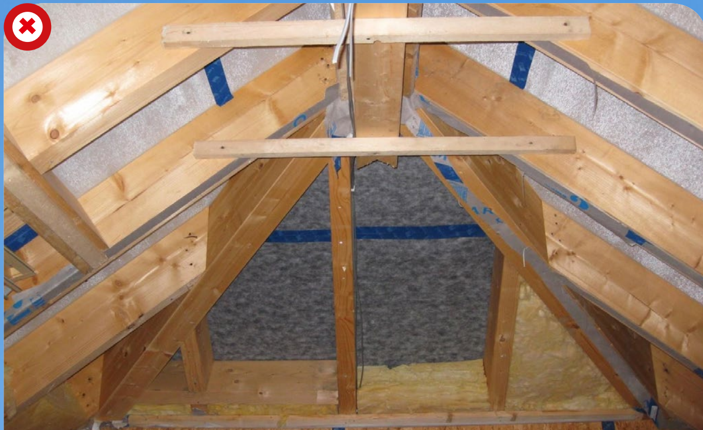
Kondenzace vzdušné vlhkosti na nekvalitní pojistné hydroizolaci (světlá fólie) a nulový výskyt kondenzátu na kontaktní pojistné hydroizolační fólii Solitex® plus (tmavší fólie) za stejných podmínek na stejné konstrukci.
