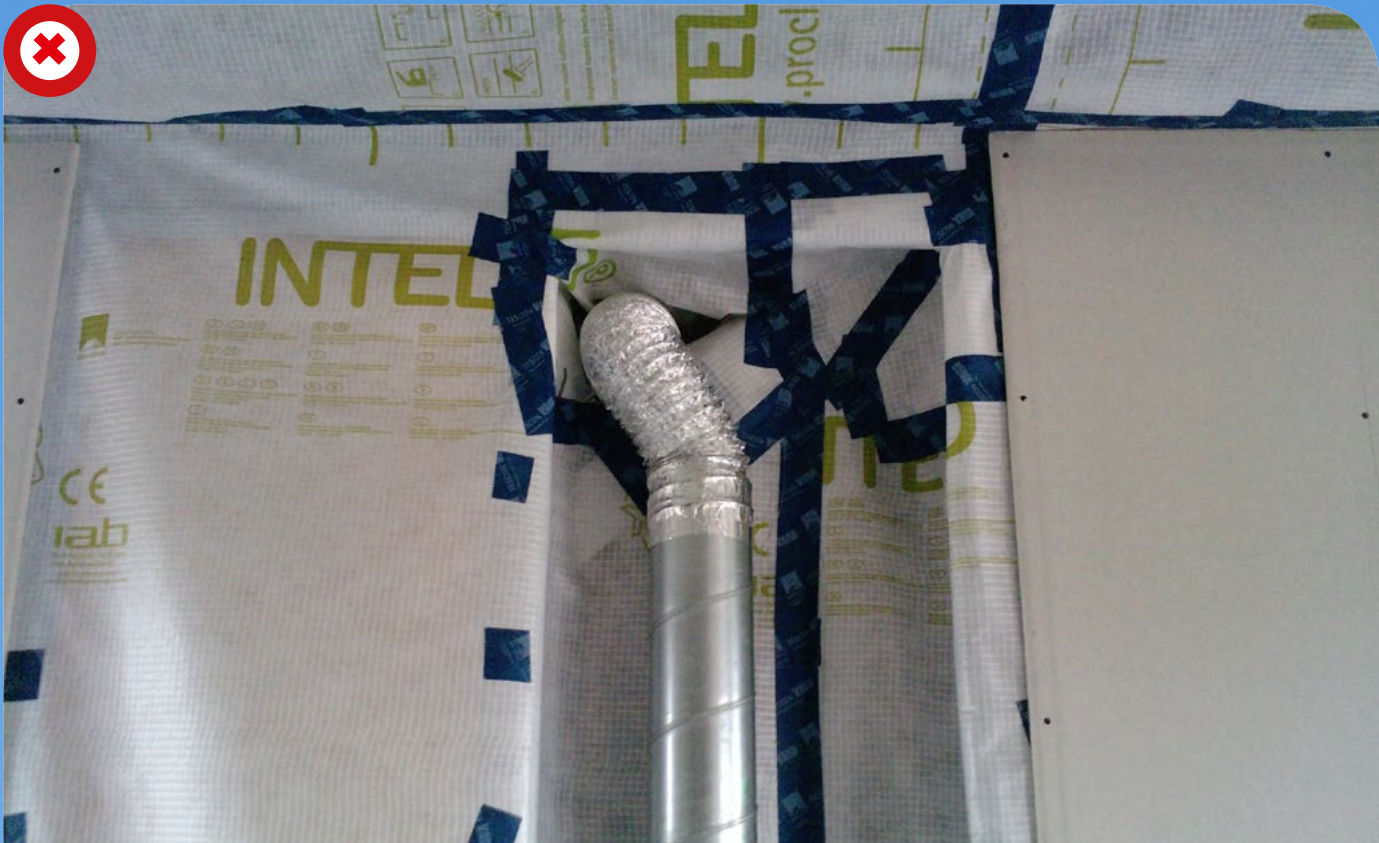
Nesystémové zajištění vzduchotěsnosti prostupu parobrzdou
